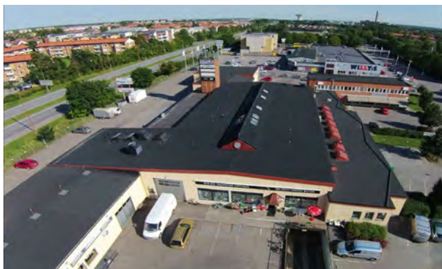
Ihus solcellsanläggning på Björkgatan 4 i Uppsala.
